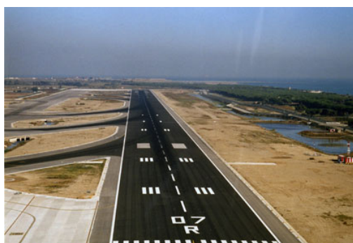
Figura 2: Cabecera de pista del Aeropuerto internacional de El Prat (Barcelona).
